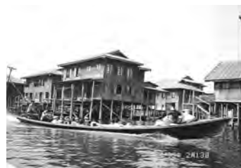
インレー湖上の民家、水面上に高床式木造の家をつくっている。電気が来ている家と、発電機に頼っている家とがある（シャン州）
